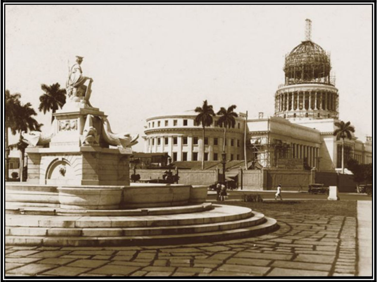
Figura 2. Capitolio Nacional de La Habana en construcción, aproximadamente en 1928. La imagen permite apreciar la fase final de levantamiento de la cúpula, poco antes de la inauguración de 1929. (Wikipedia)
