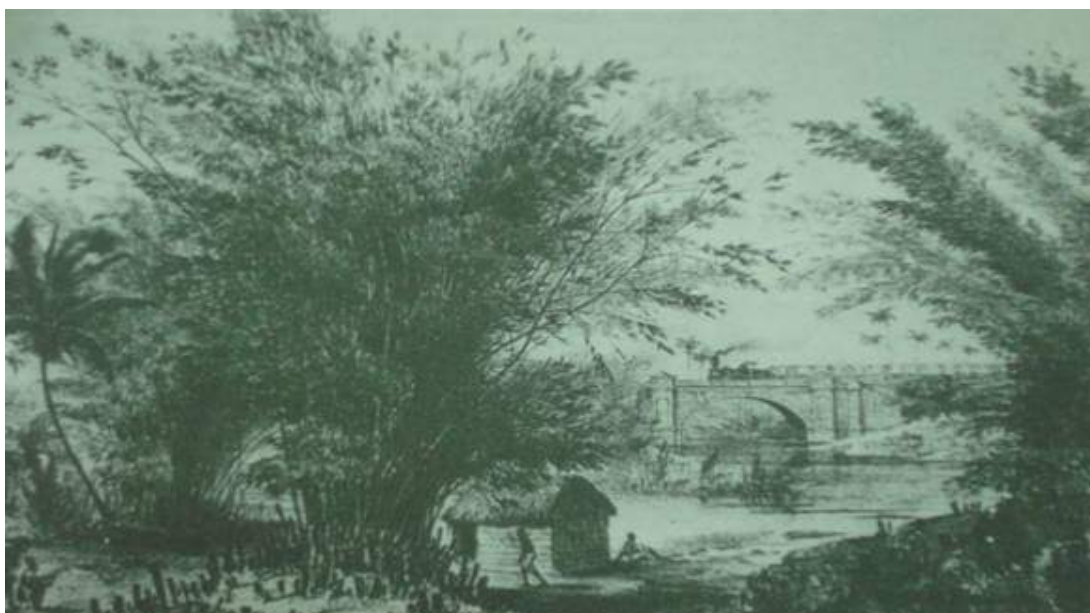
Primer puente construido sobre el Río Almendares
