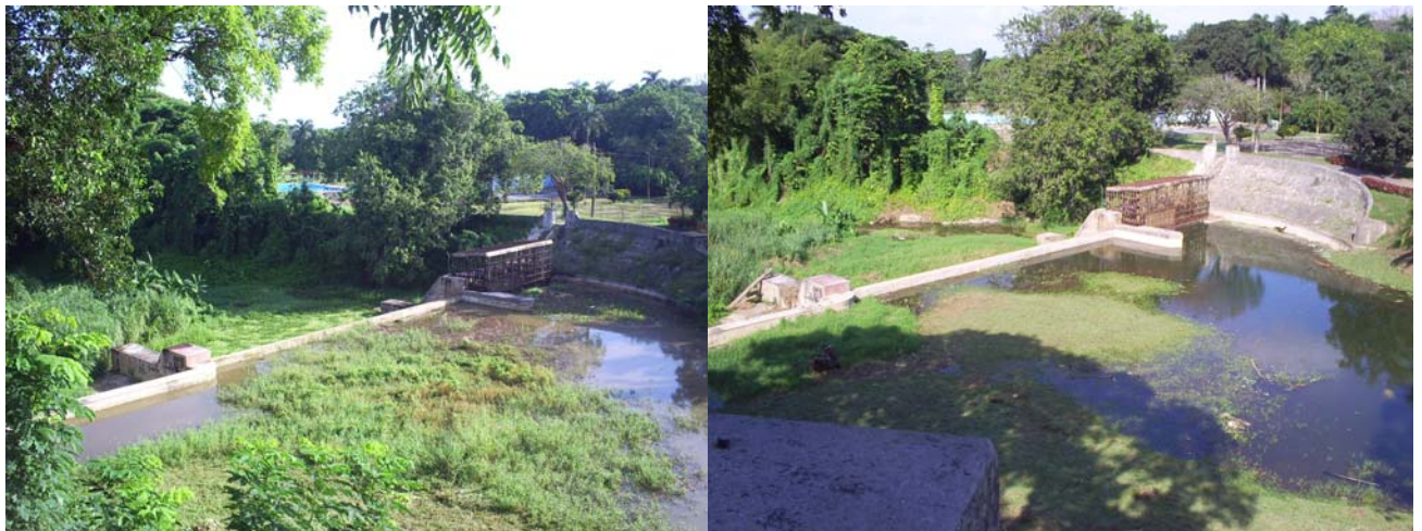
Fotos de la represa de hormigón, río Almendares (20 de agosto y noviembre de 2011)
