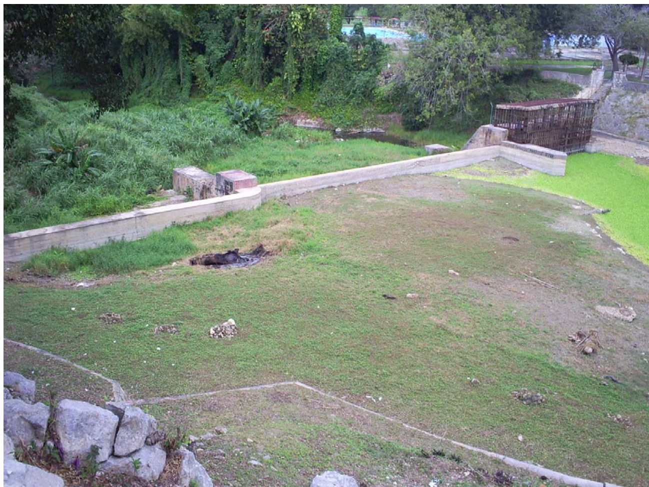
Represa de hormigón construida en 1949, río Almendares 4 de febrero de 2012
