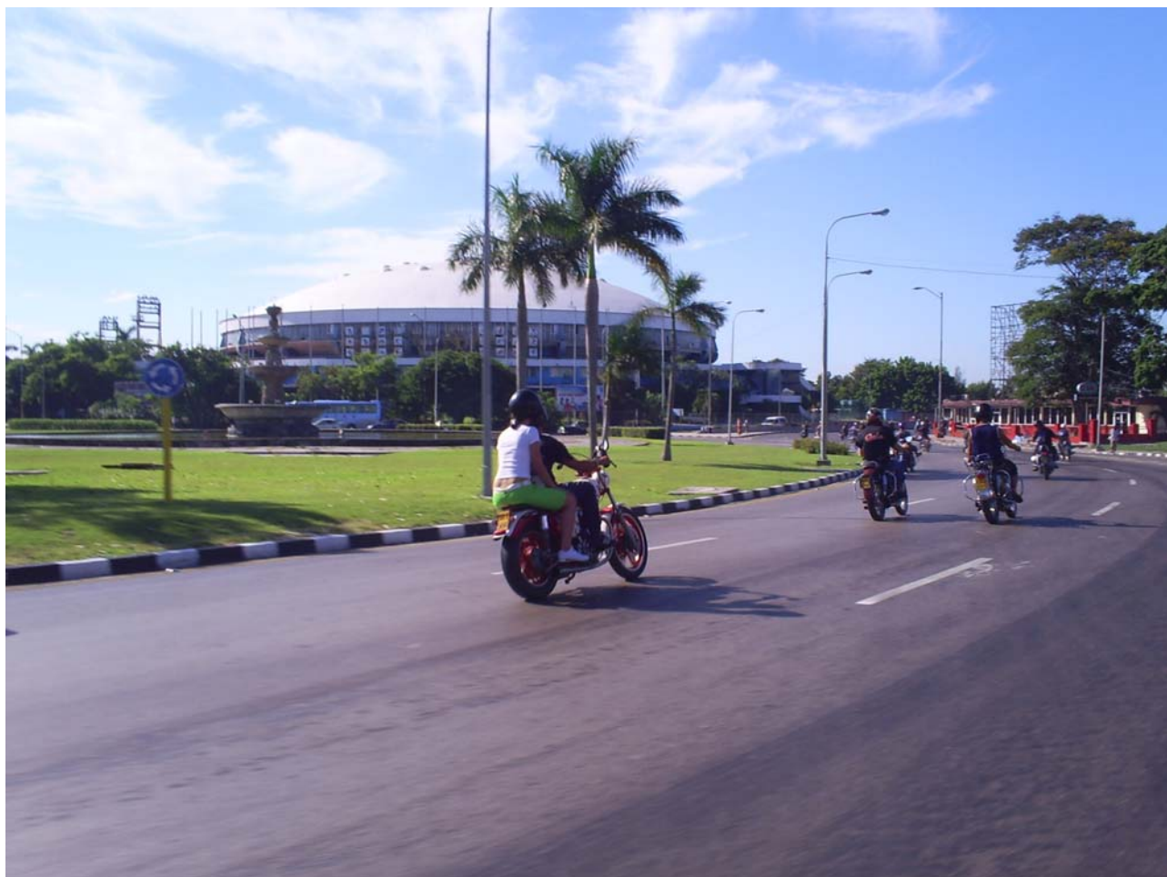
Rotonda de la Fuente Luminosa
